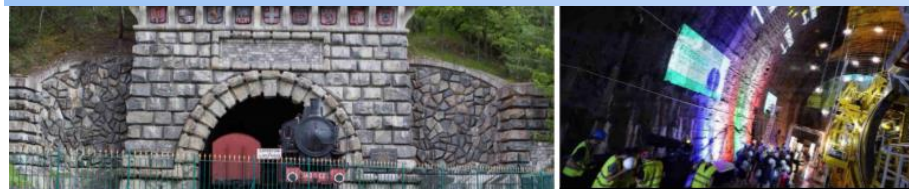
Brennero: il Tunnel di base a 150 anni dall'inaugurazione della ferrovia storica (1867)
