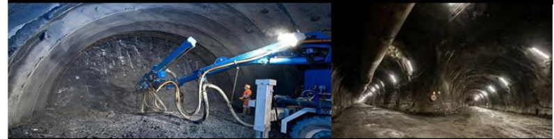
La realizzazione del tunnel del Brennero
